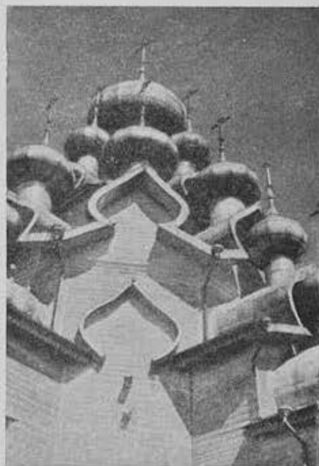
Кижский погост. Двадцатидноглавая церковь. Деталь кокошиков
