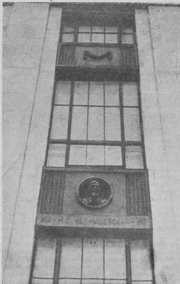
Fragment de la façade
