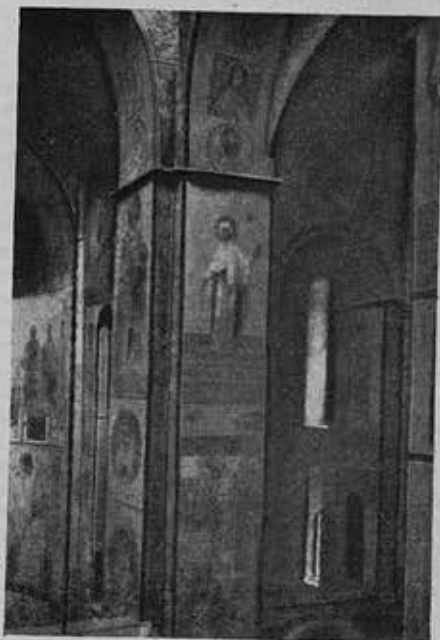
Один из центральных столбов Кирилловской церкви (хорошо виден шиферный карниз у основания подпружных арок)
