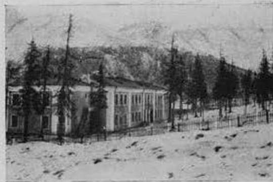
Школа под Кировском. Арх. Покровская. 1934 г.
