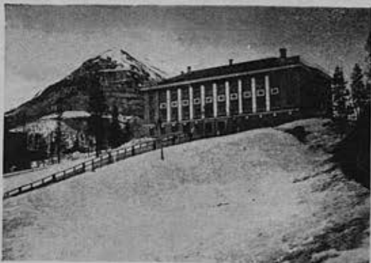
Школа в поселке Кукисвумчорр. Постройка 1938 г.
