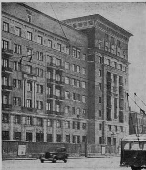
Непродуманное композиционное решение, грубые детали, не увязанные с типом здания и с методами стройки (жилой дом на 1-й Мещанской улице в Москве)
