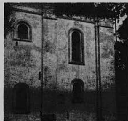
Северная стена Кирилловской церкви (ясно видны щелевидные окна внутренней лестницы на хоры)
