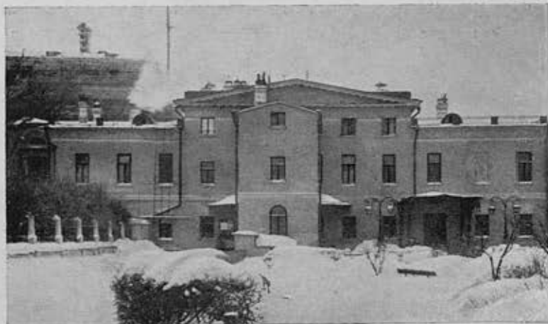
«Высокие горы». Дворовый фасад главного корпуса
