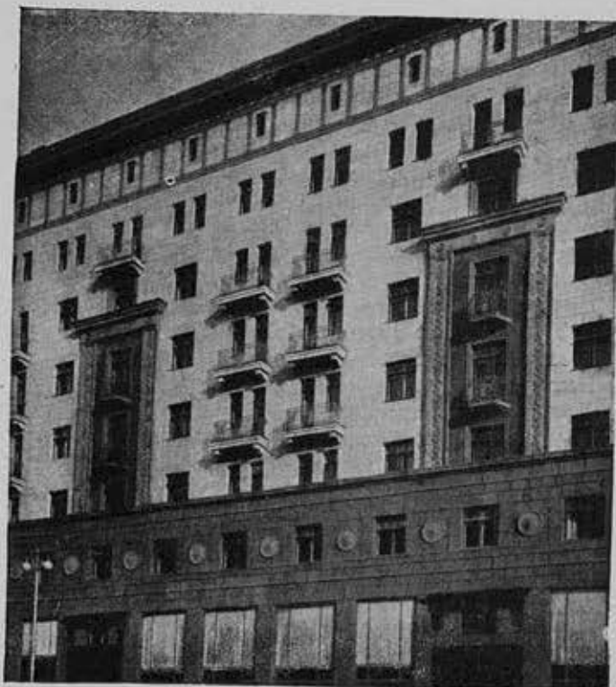
Корпус Б. Фрагмент фасада
