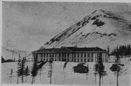
Школа в поселке Кукисвумчорр. Постройка 1938 г.
