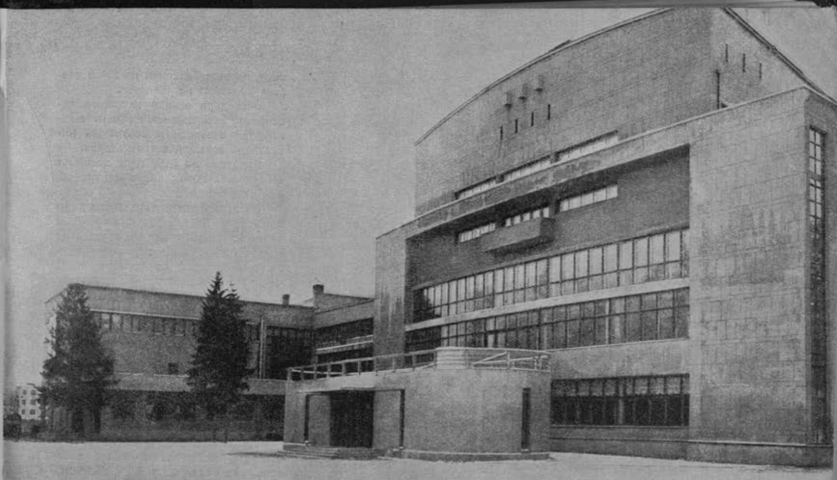
Дворец культуры завода им. Горбунова в Филях (Москва). Арх. Я. А. Корнфельд Palais de la culture de l'usine Gorbounov à Fili (Moscou), Arch. J. A. Kornfeld
