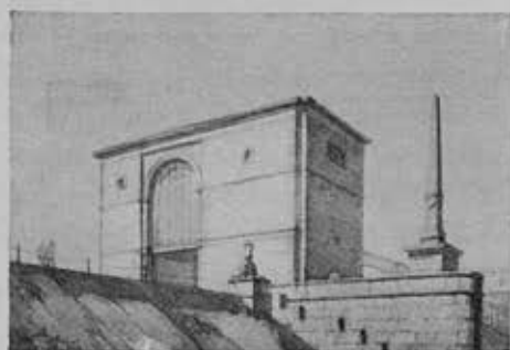
Крановое здание плотины Ст. арх. Д. Б. Савицкий
