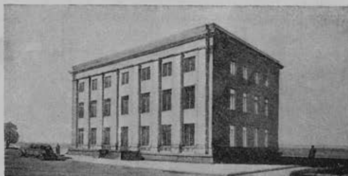
Административный корпус управления ГЭС. Арх. Э. Г. Кильпе
