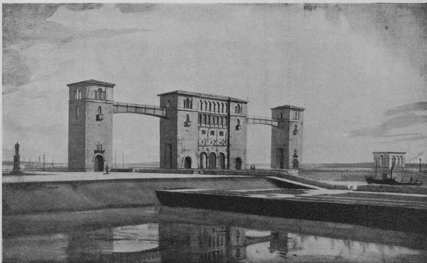
Рыбинский гидроузел. Башни управления верхней головы шлюза. Ст. арх. Д. Б. Савицкий, соавтор арх. М. Л. Шпекторов
