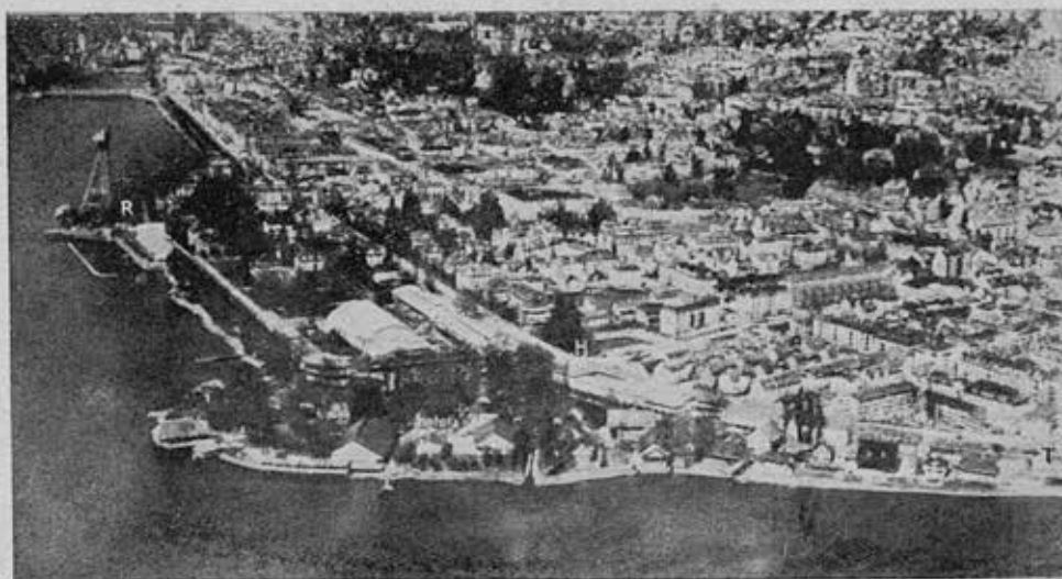
Швейцарская выставка 1939 г. в Цюрихе. Общий вид
