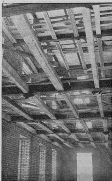
Строительство жилого дома на Можайском шоссе в Москве. Перекрытие
