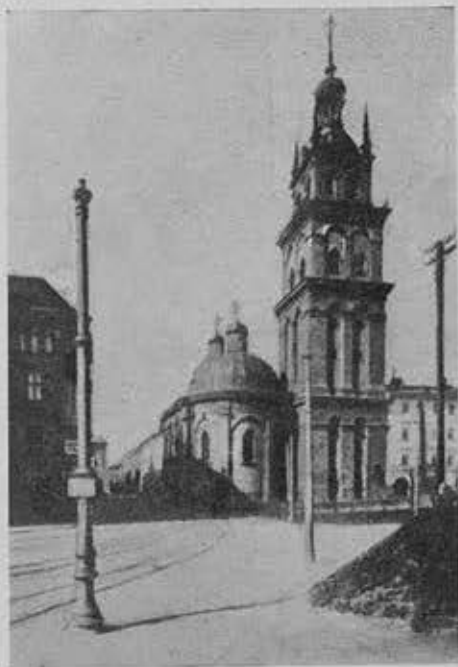
г. Львов. Валахская церковь. 1570—1630 гг. Lvov. Eglise Valaque. 1570—1630
