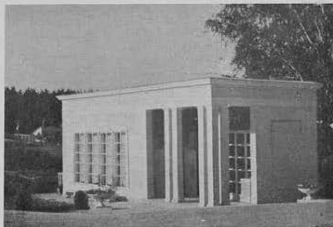
Колхозная автоматическая гидроэлектростанция Hydrocentrale kolkhozienne
