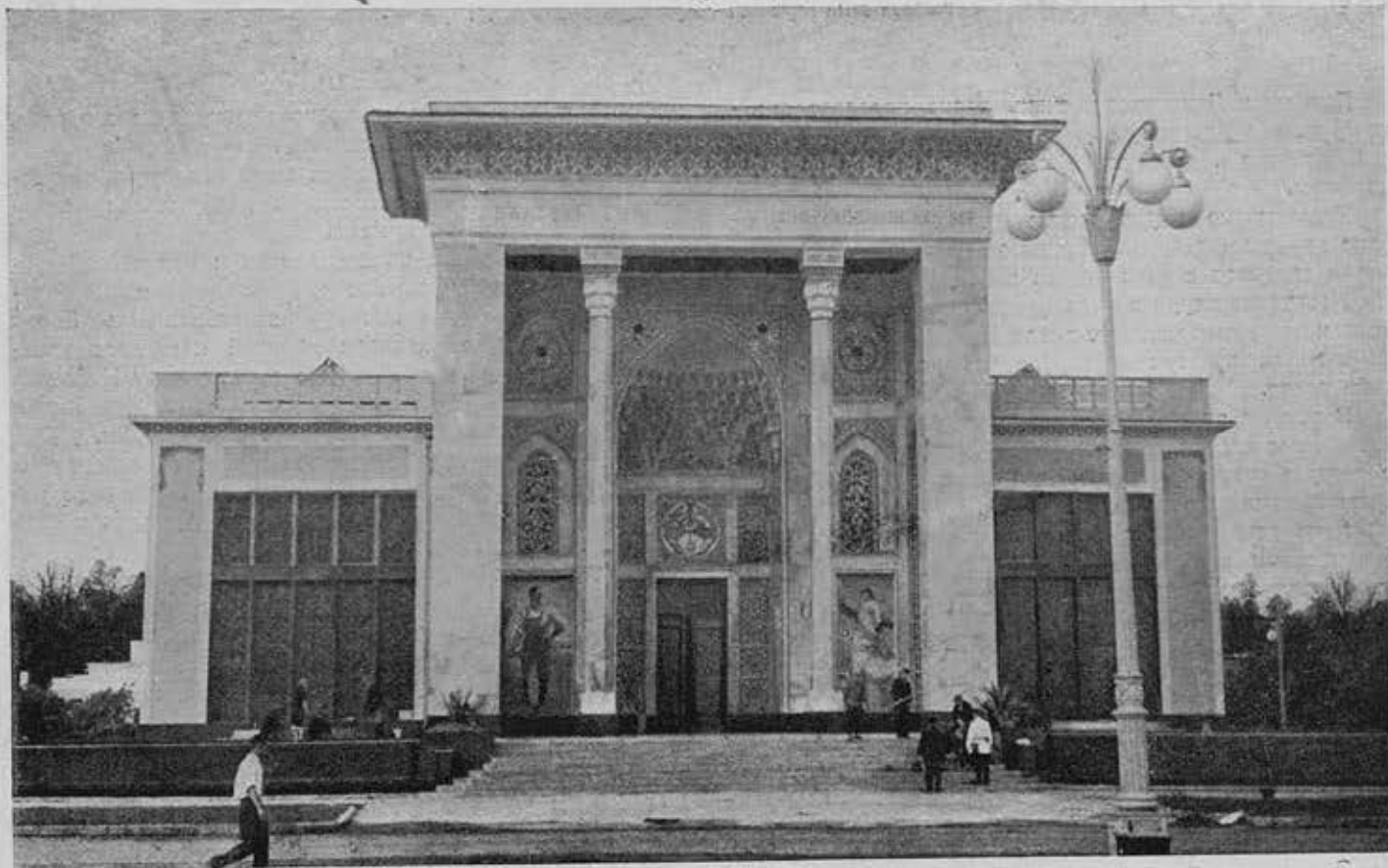
Павильон Азербайджанской ССР. Арх. М. Усейнов, С. Дадашев Pavillon de la R.S.S. d'Azerbaïdjan. Arch. M. Ousseïnov, S. Dadachev
