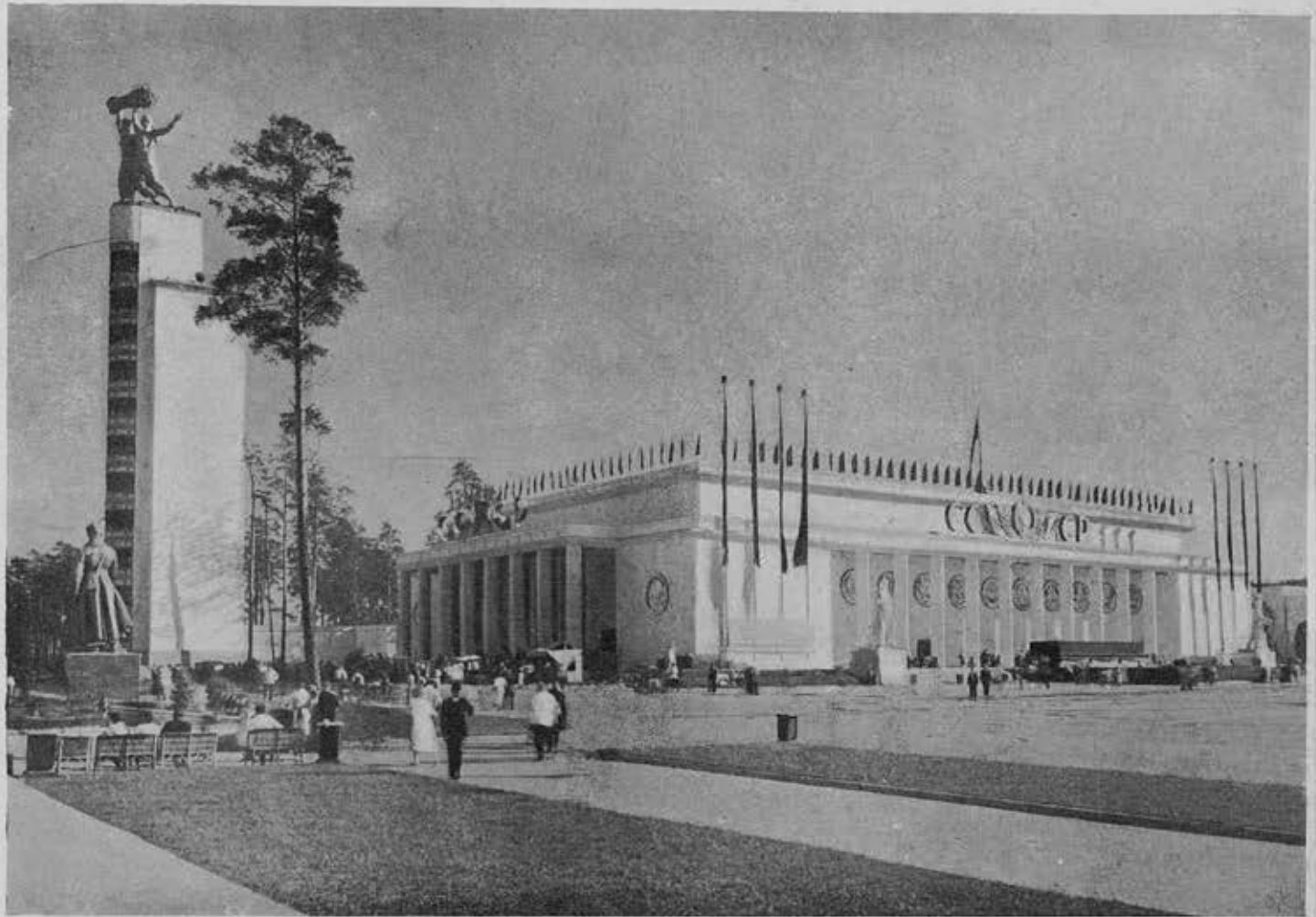
Главный павильон, Акад. арх. В. А. Шуко, проф. В. Г. Гельфрейх, арх. А. П. Великанов, арх. Ю. В. Шуко
