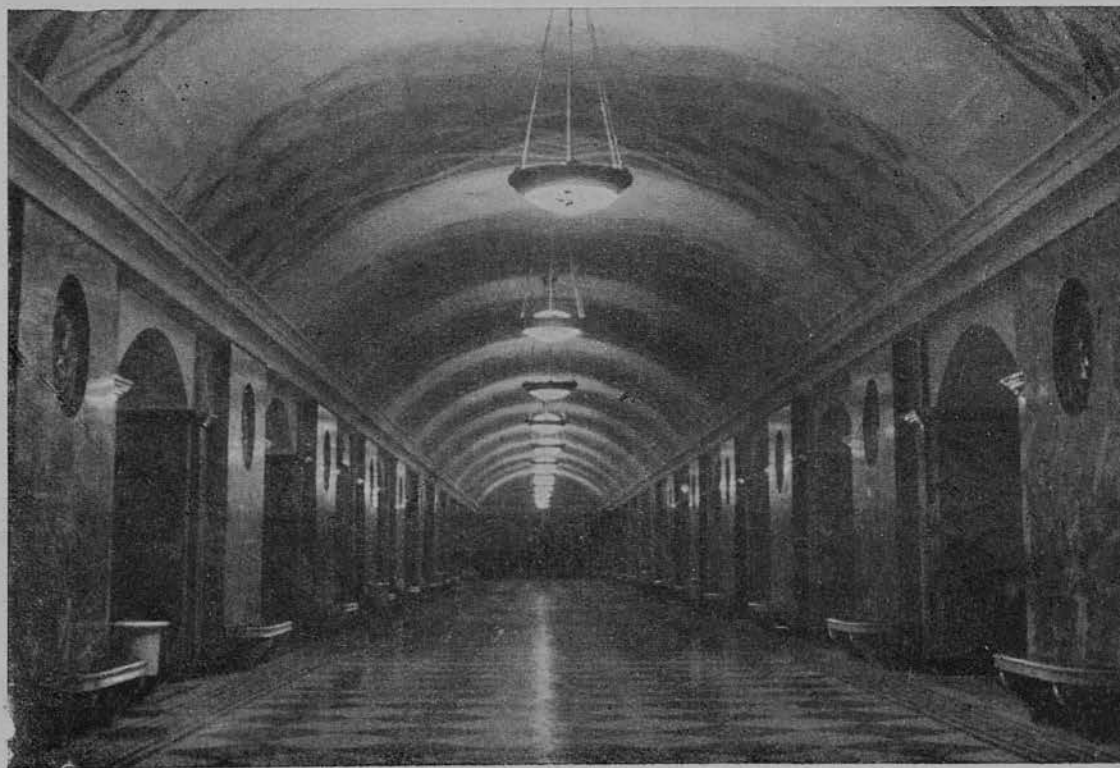
Station de métro „Gare de Koursk“ Arch. L. Pollakov
