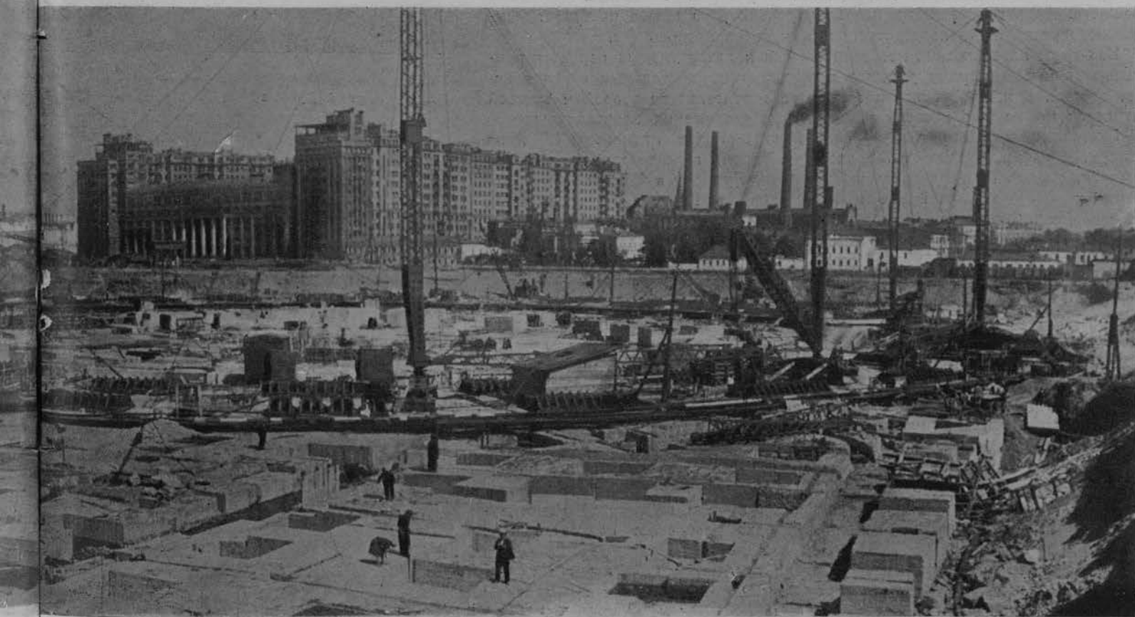
Palais des Soviets. Vue générale du chantier
