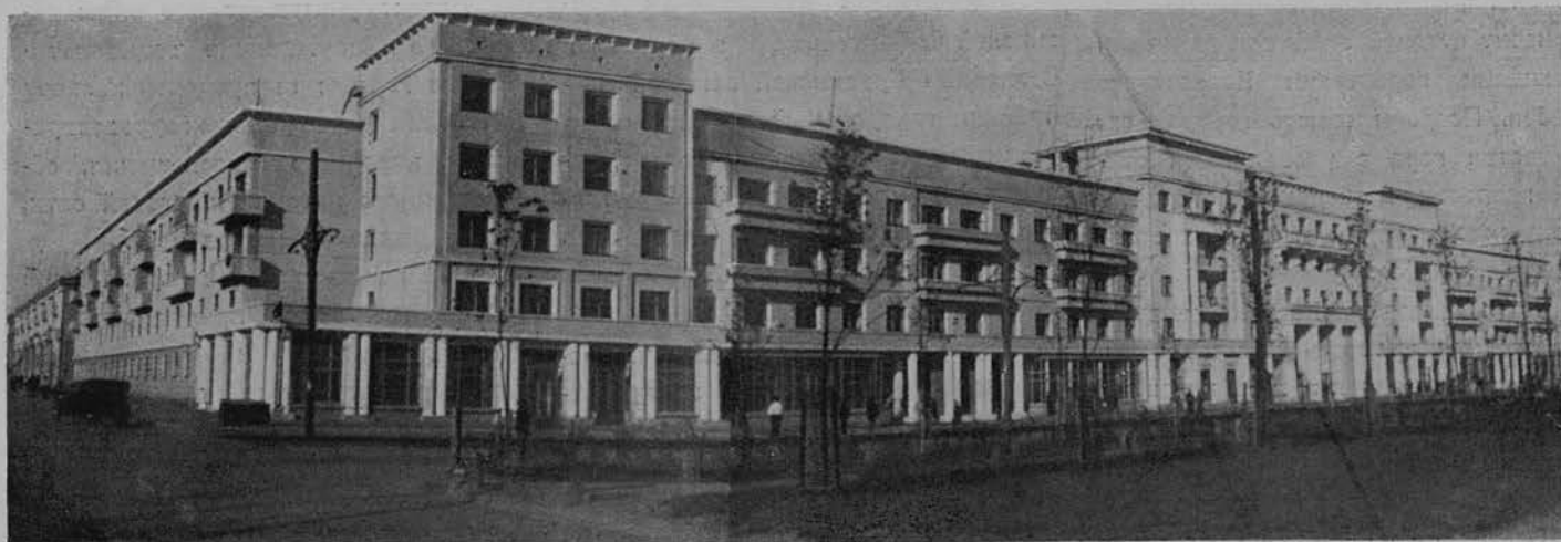
Жилой дом автозавода в г. Горьком. Арх. М. Любофеев Maison d'habitation de l'usine d'automobiles à Gorki. Arch. M. Liouboféev
