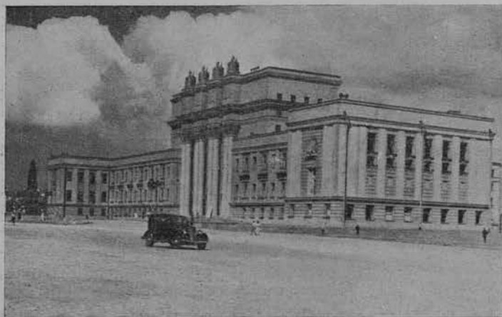
Дом культуры в Кузбассе. Арх. Катценелbogen и Н. А. Троцкий Maison de culture à Kouïbychev. Arch. Katzenelenbogen et N. A. Trotski
