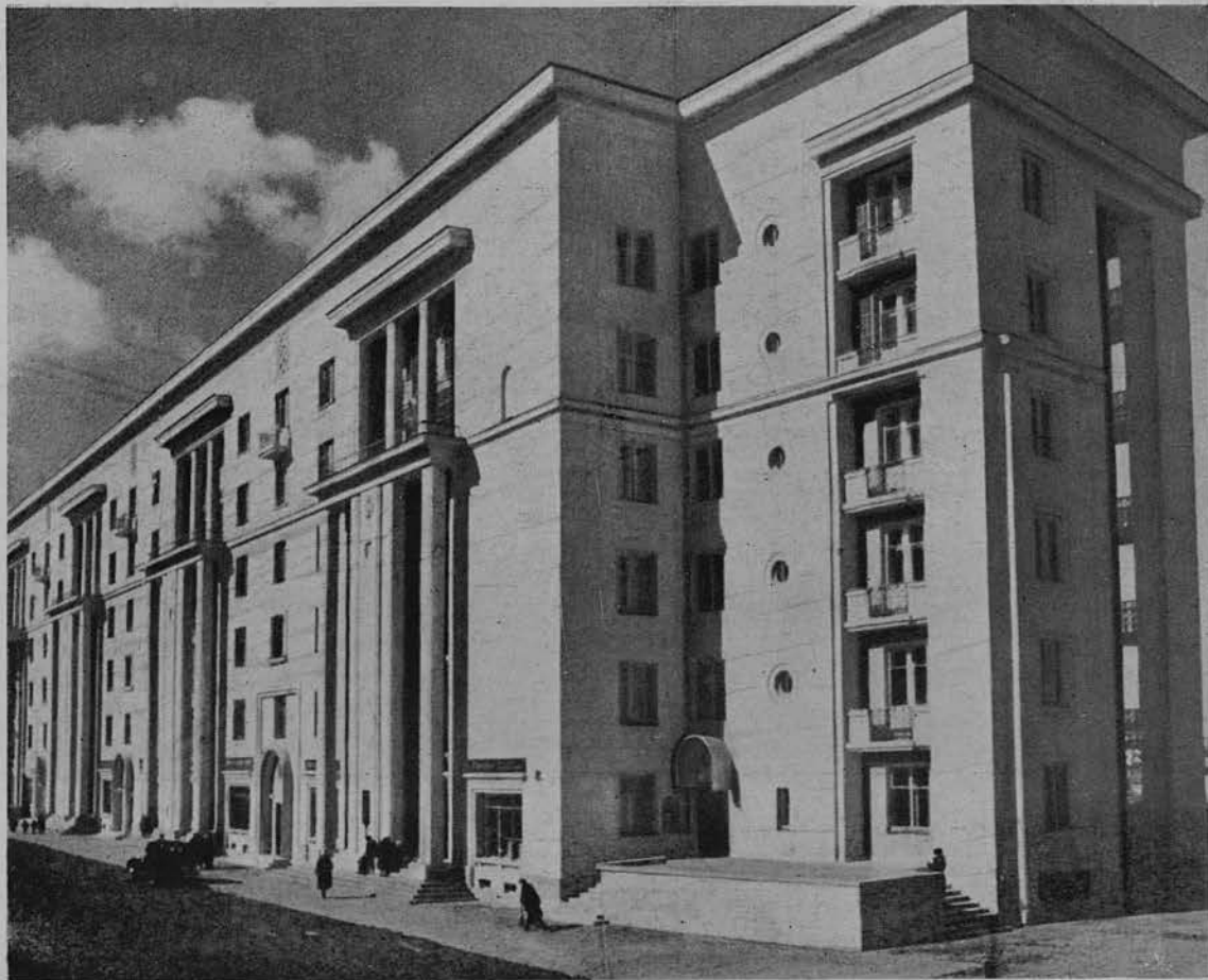
Жилой дом в Ленинграде Арх. Е. А. Левинсон, И. И. Фомин, С. С. Пясковская Maison d'habitation à Léningrad. Arch. E. A. Levinson, I. I. Fomine, S. S. Piaskovskaia
