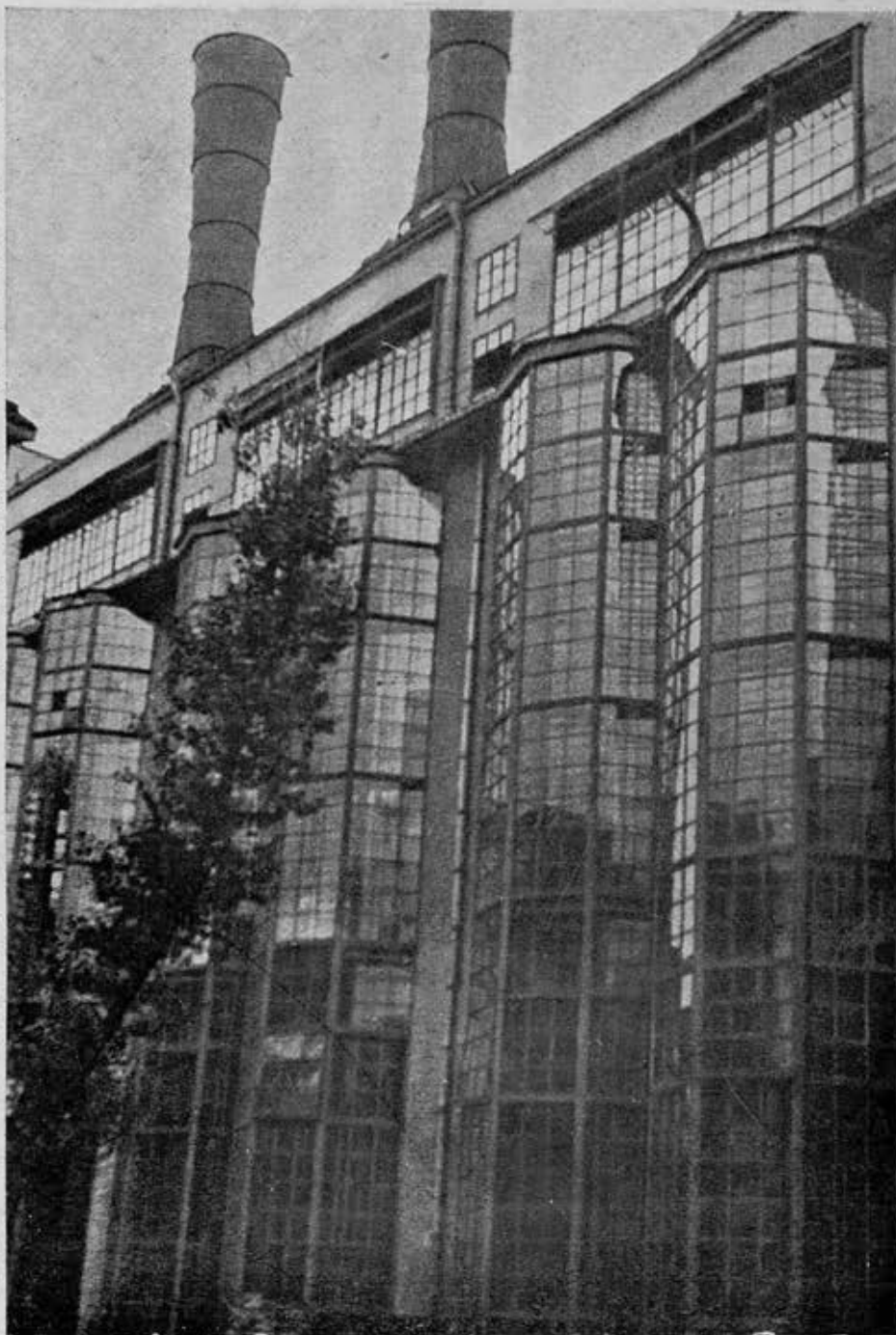
Котельная Могэс Арх. И. В. Жолтовский
