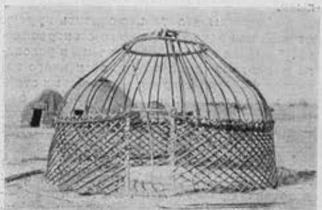
Деревянный сборный каркас юрты La carcasse en bois démontable de la yourte
