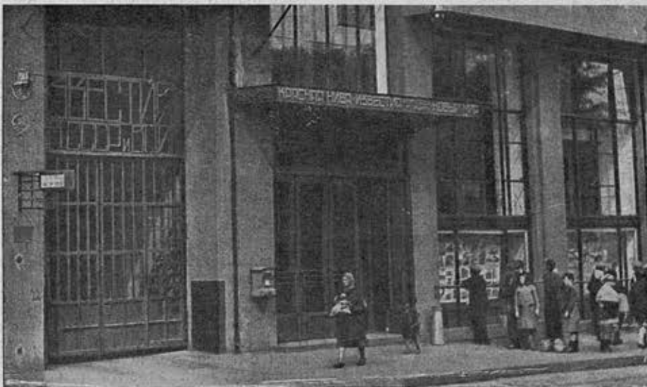
Дом «Известий» ВЦИК в Москве. У ворот защитные железные углы. Надписи и указатели вписаны в фасад согласно проекту. Низ дверей имеет защитную обивку
