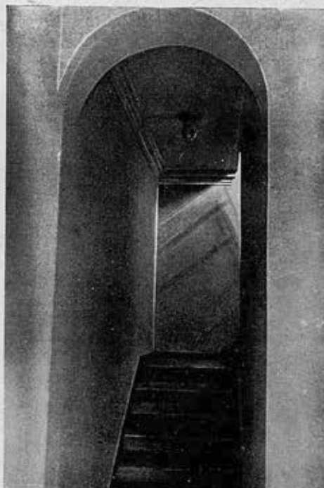
Лестница в одной из квартир 6-го этажа
