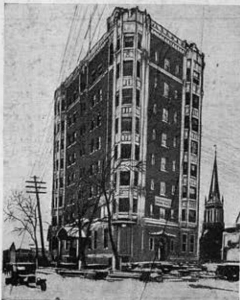
Восьмизэтажный с железным каркасом жилой дом в Альбани. В 1827 году передвинут в двух направлениях на 129 м и опущен на 1,27 м
