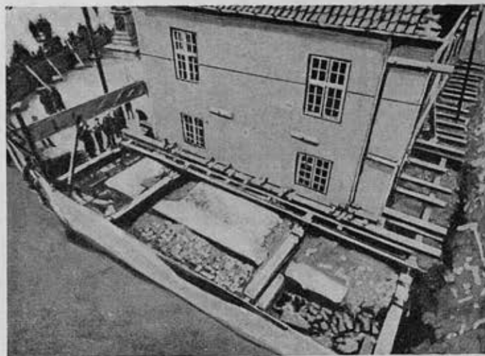
Ратуша в г. Рандерсе (Дания). Здание в стадии частичного сдвига со старого фундамента
