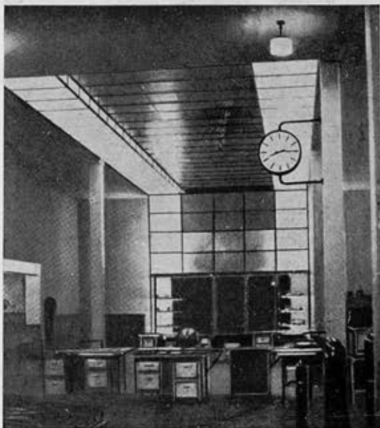
Установка для искусственного верхнего света коробчатой формы Plafond lumineux en forme de boîte
