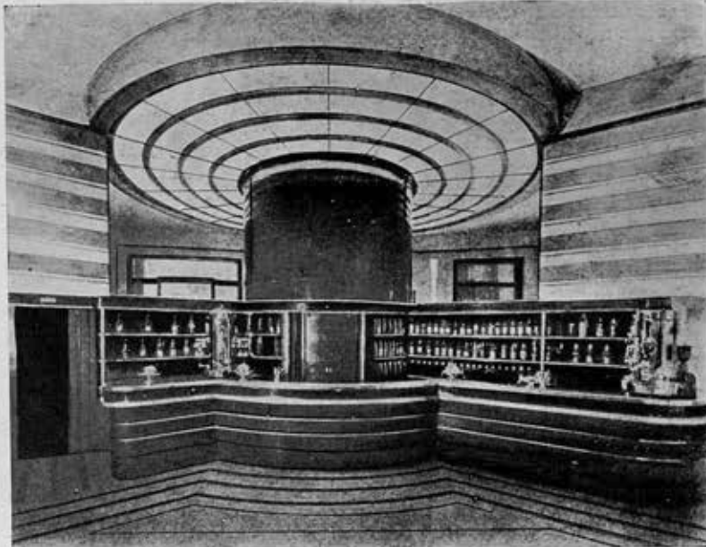
Осветительная установка в виде концентрических колец охватывающих колонну
