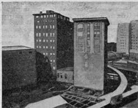
Телефонная станция в Индианополисе Прямолинейное передвижение закончено Здание приоткрыто к повороту
