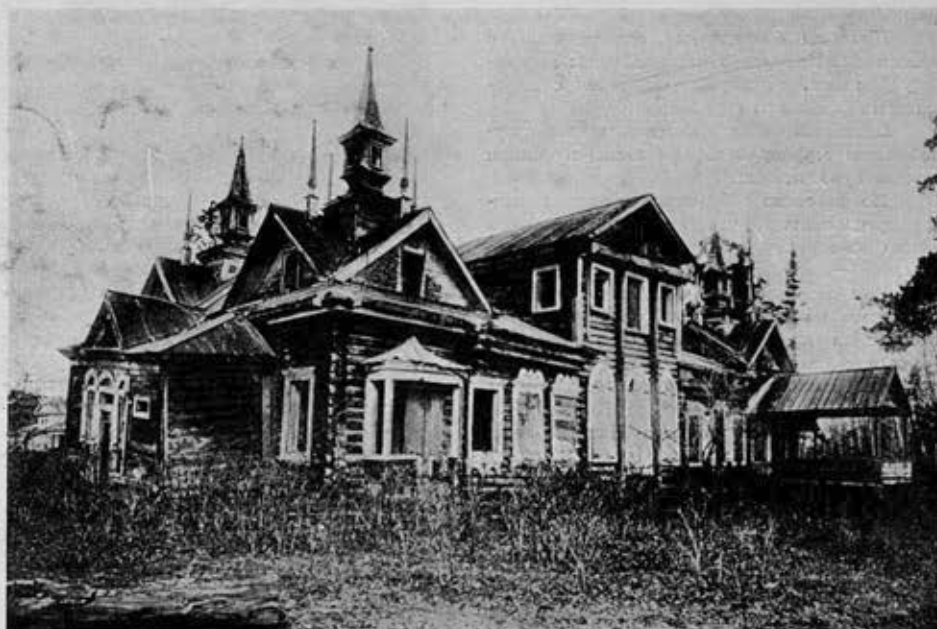
Дом в Степановке. Фасад
