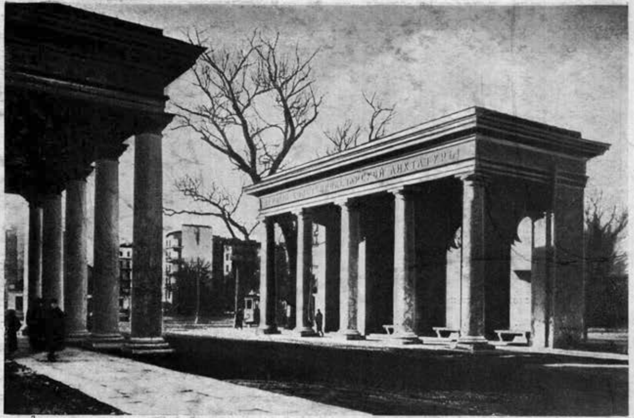
Въезд в Смольный 1924 г. Ленинград Акад. арх. В. А. Шуко, проф. В. Г. Гельфрейх
