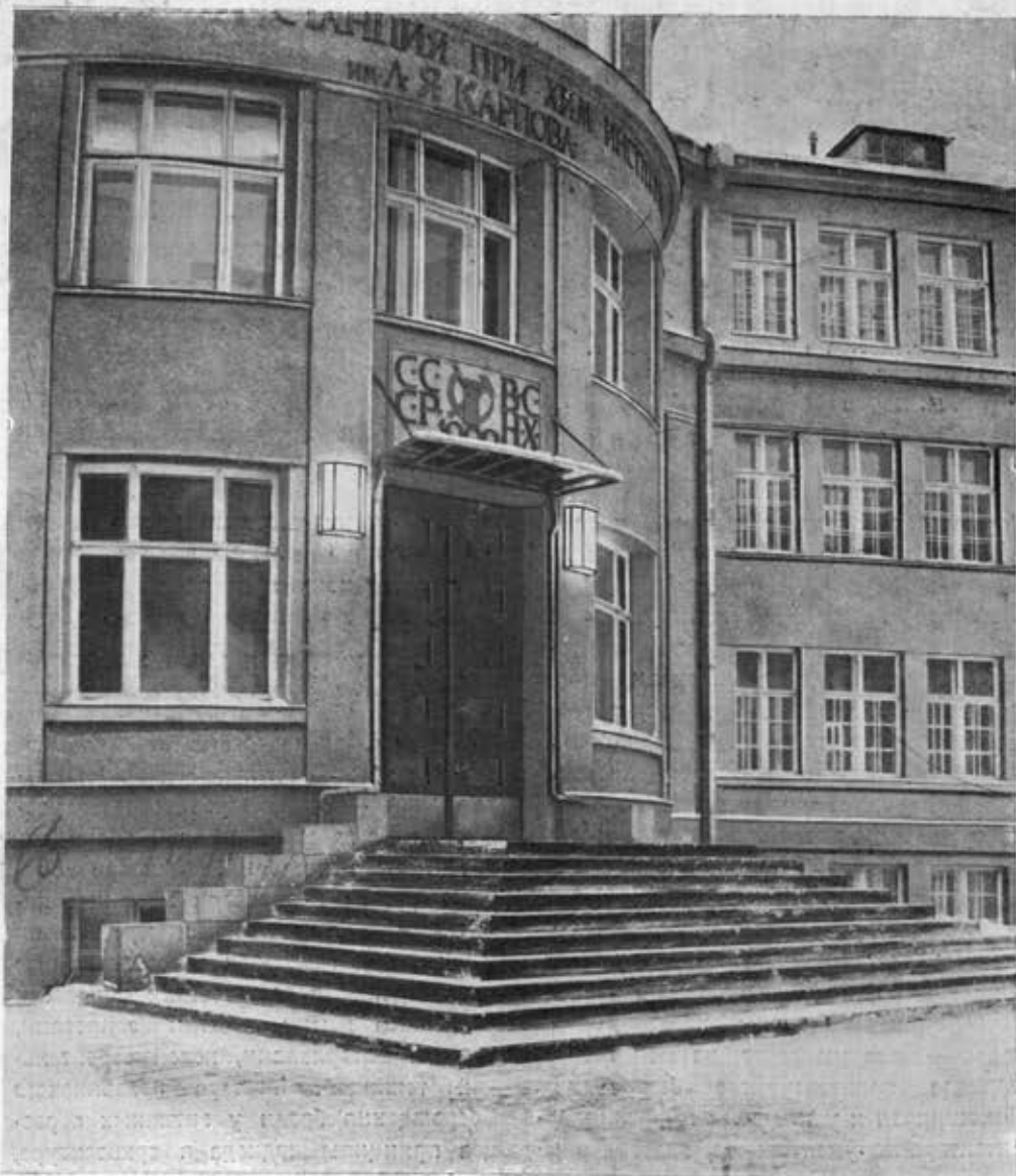
Détail de la façade
