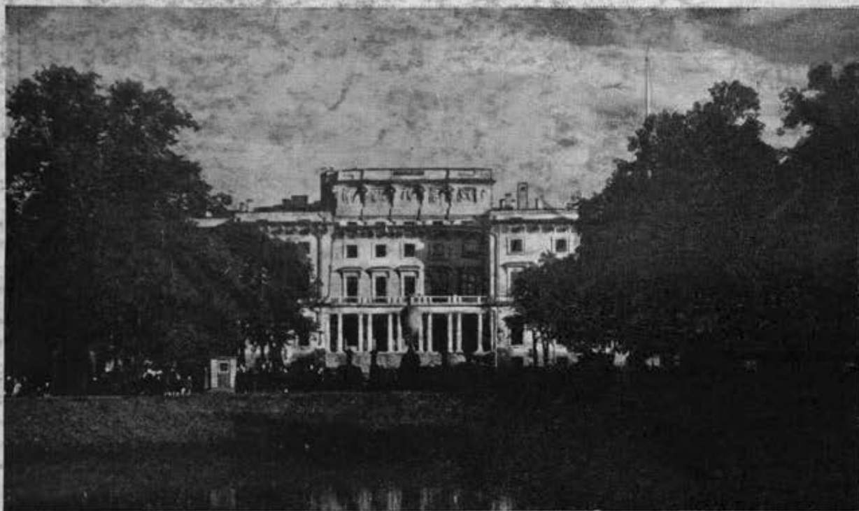
Фасад Инженерного замка со стороны Летнего сада Арх. В. Бренна
