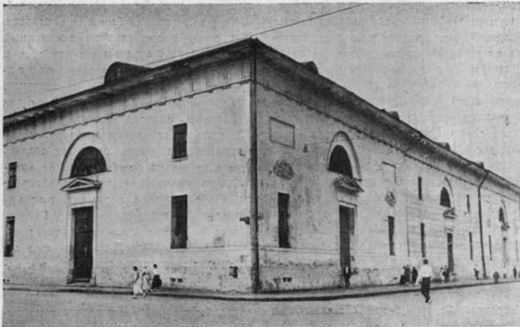
Ancien Immeuble de l'Intendance, place de la Crimée. Commencement du XIX-me siècle Arch. D. Gilardi
