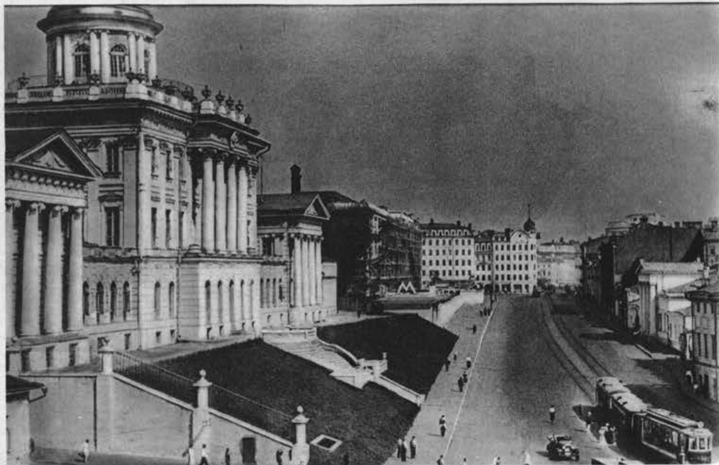
Моховая улица после реконструкции
