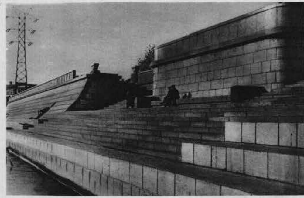
Котельническая набережная Москва-реки Причал Арх. И. А. Француз
