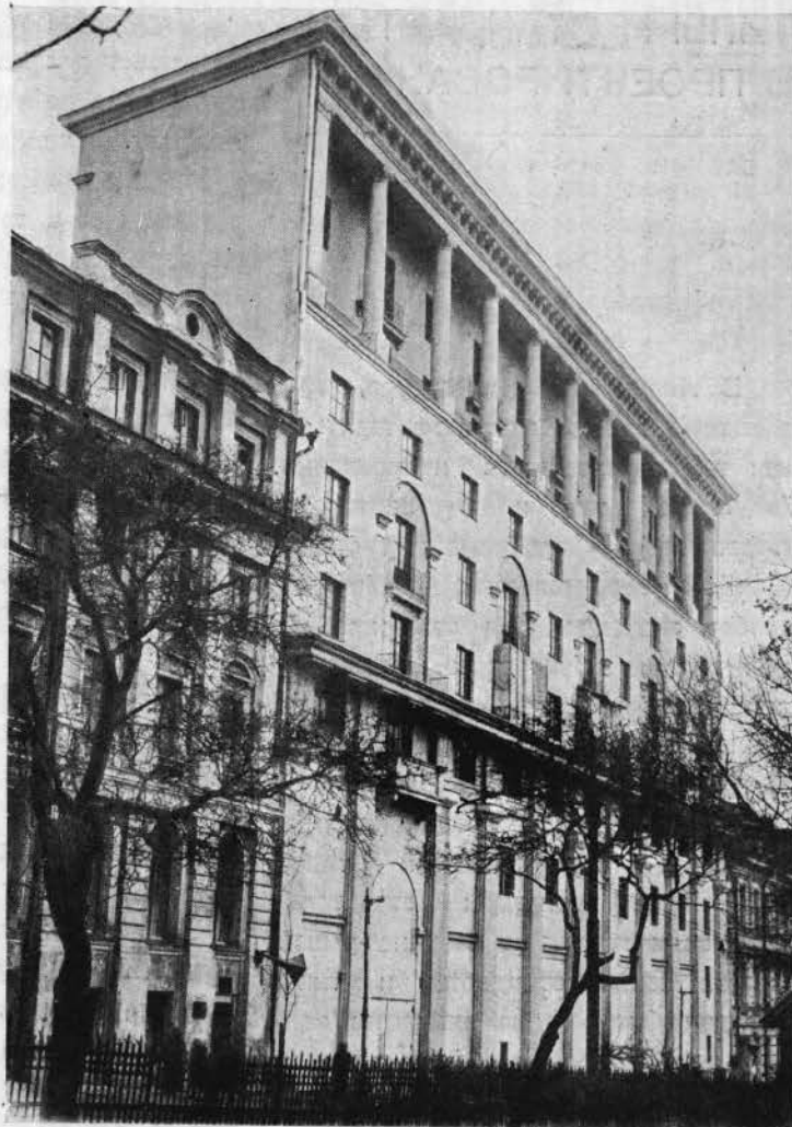
Жилой дом по Лубянскому проезду в Москве Арх. А. И. Ефимов
