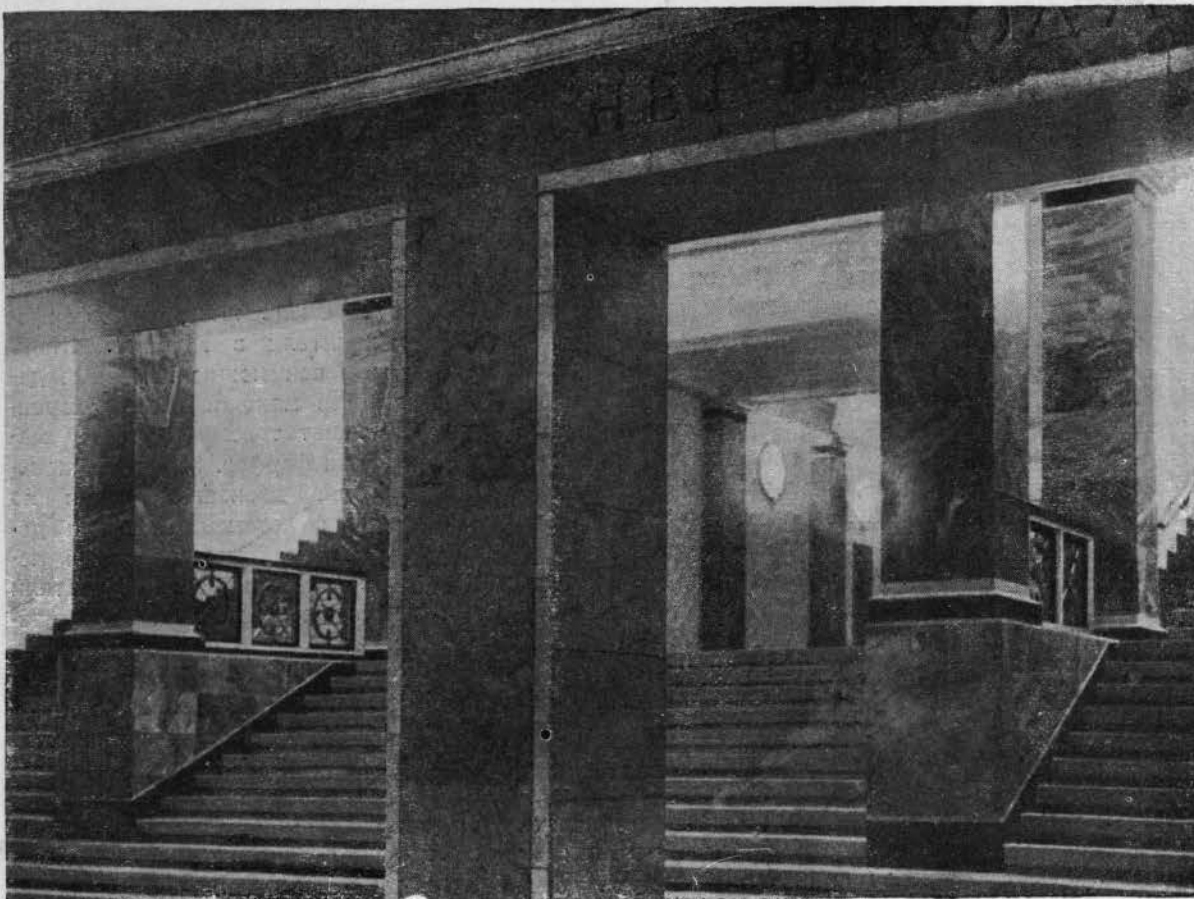
Подземный аванзал Вид на лестницу наземного вестибюля
