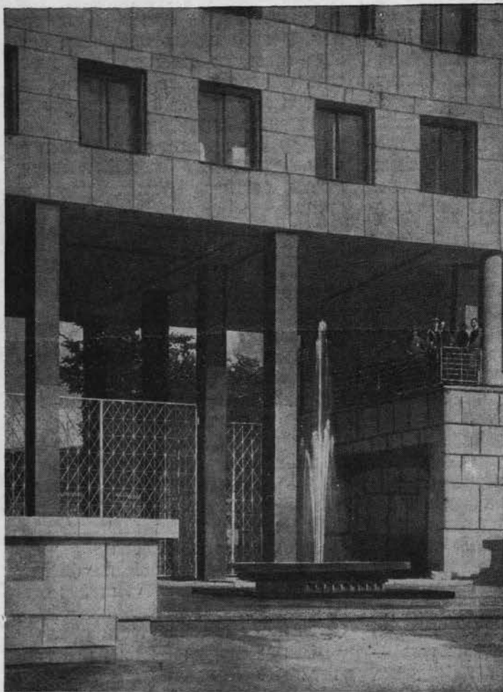
Жилой дом на набережной реки Карповки в Ленинграде Фрагмент фасада
