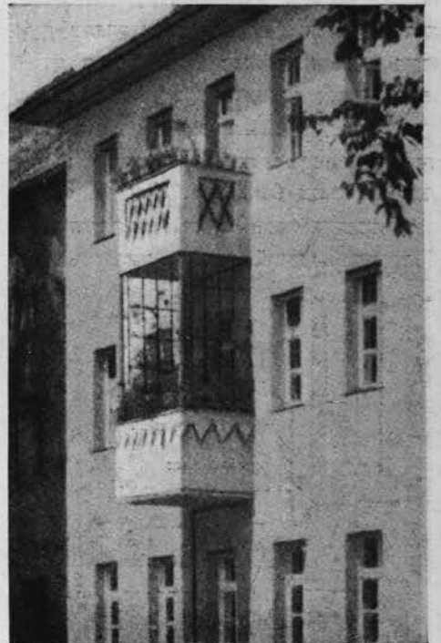
Устройство трельяжа между балконами
