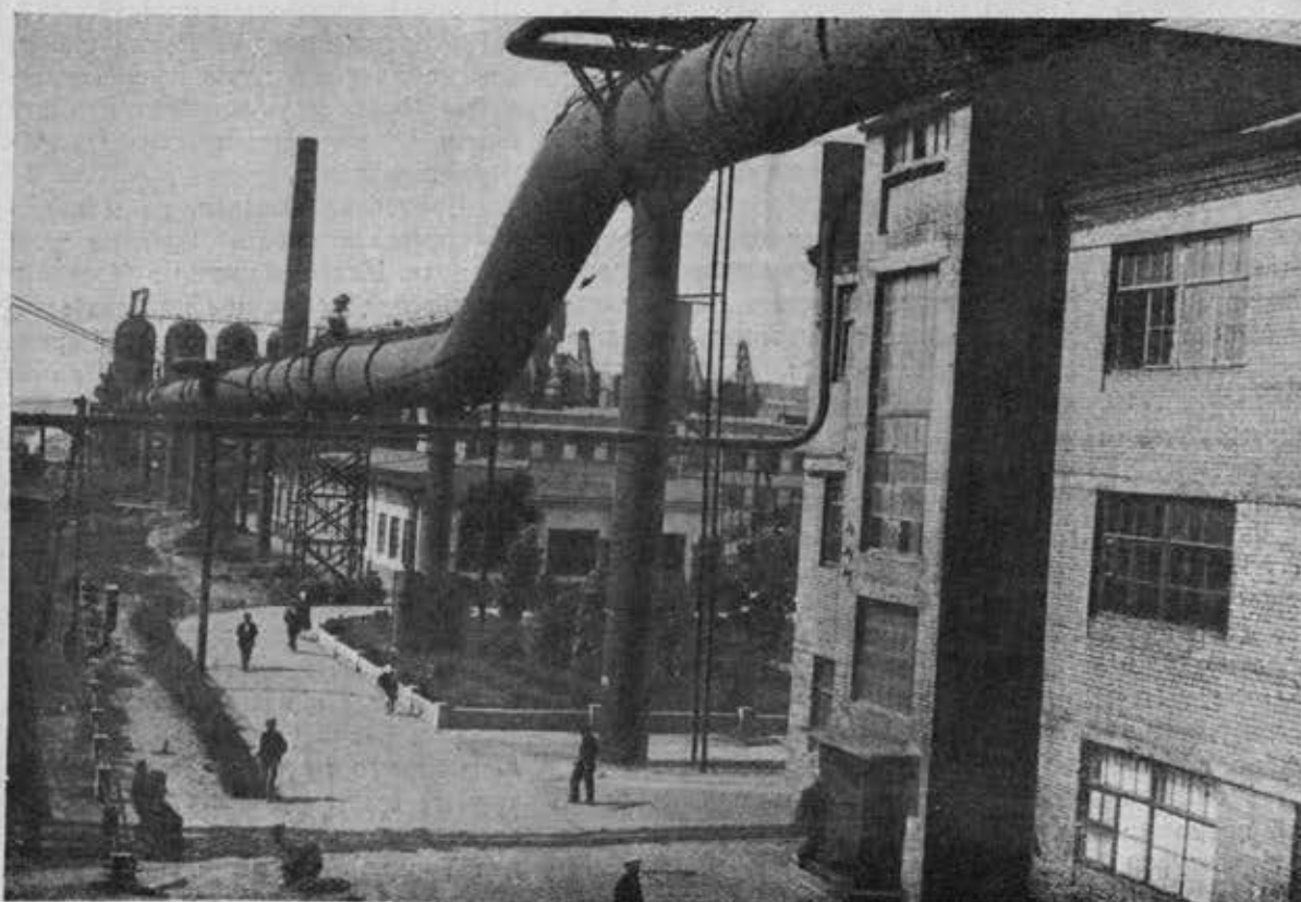
Завод «Азовсталь» Бытовые помещения мартевского цеха
