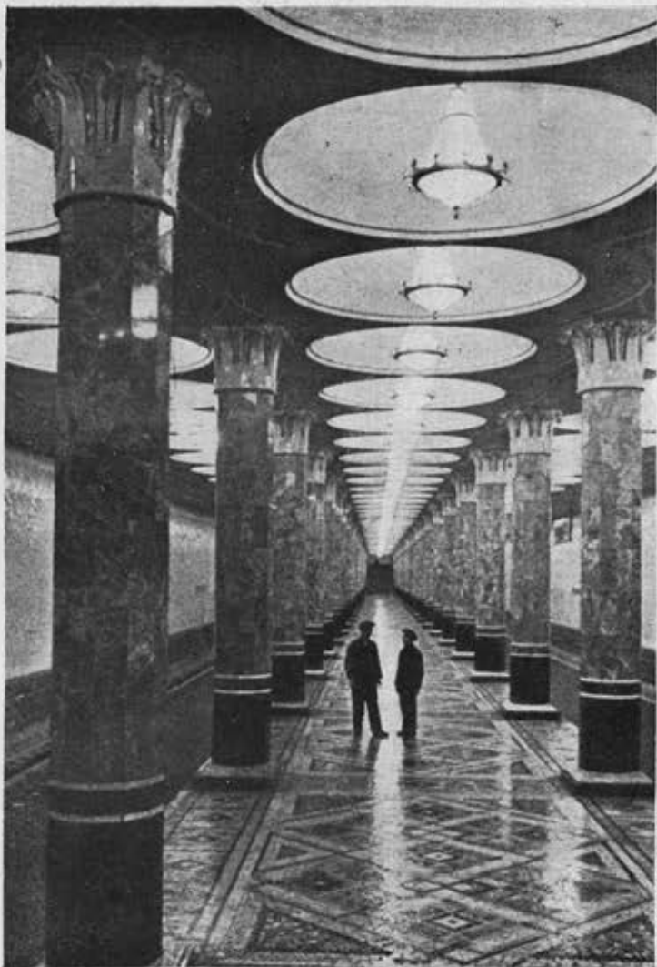
Станция метро «Киевский вокзал», Перрон Арх. Д. Н. Чечулин
