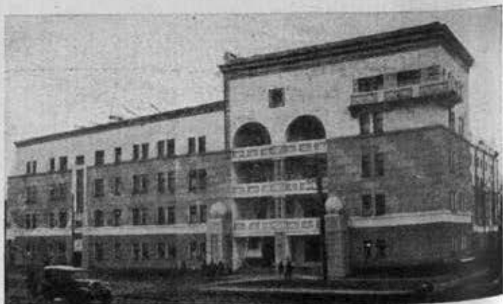
Nijni Taguil Maison d'habitation dans la cité ouvrière de l'usine de wagons d'Oural Dzerjinski
