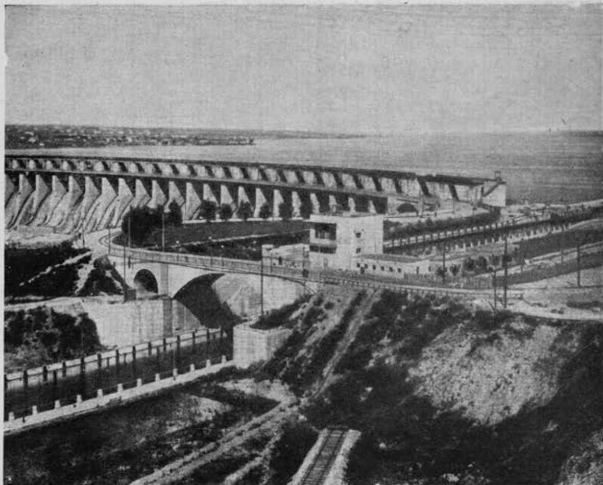
Centrale hydro-électrique Dniéprovskaja
