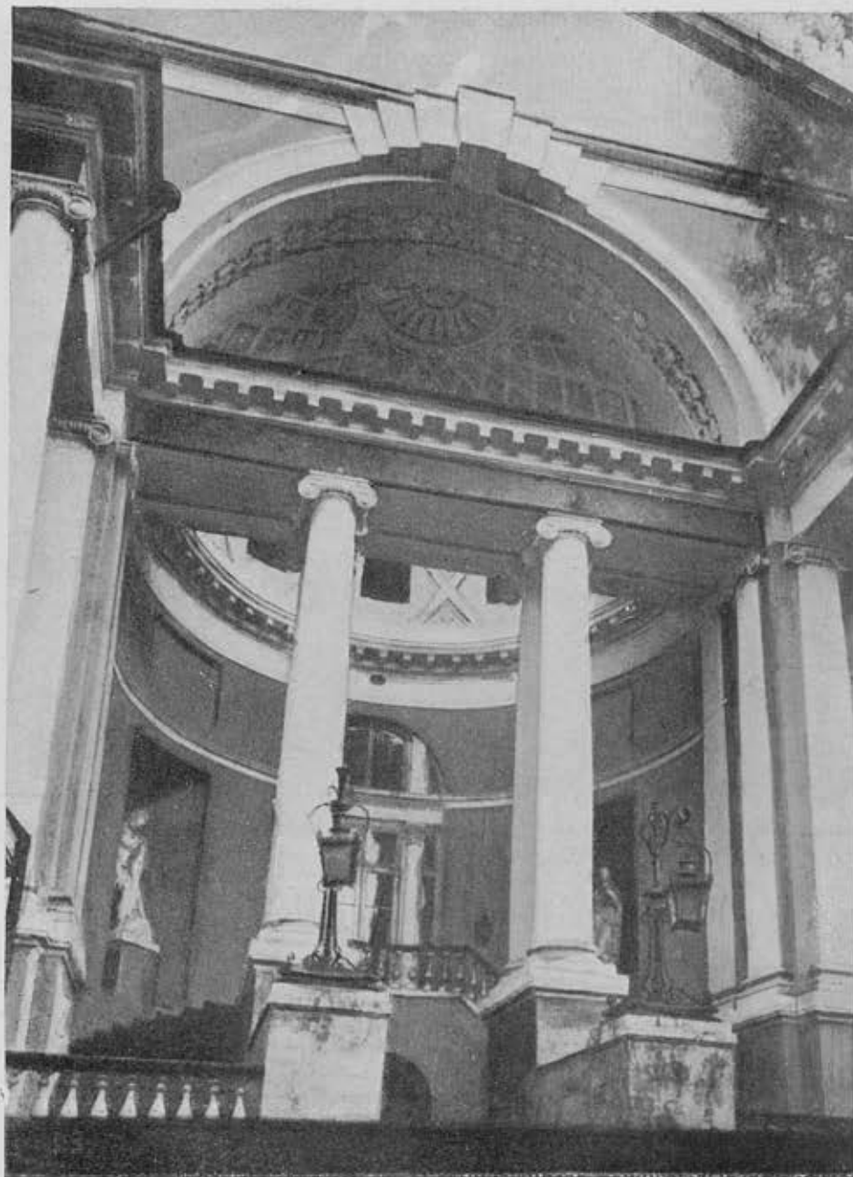
Институт физической культуры им. Сталина. Фрагмент центральной части главного фасада
