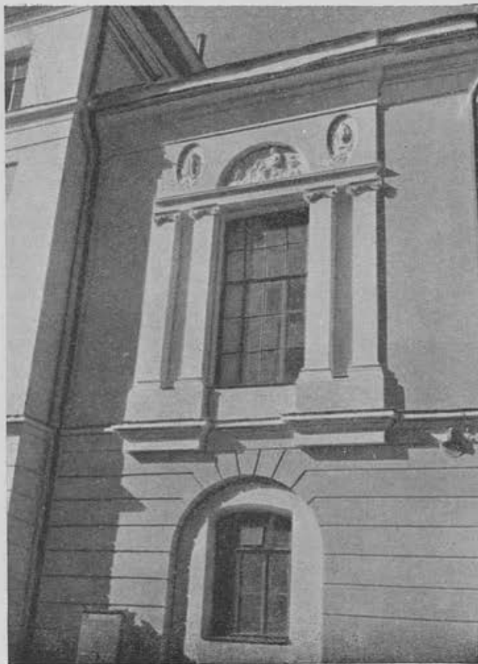
Институт физиотерапии. Детали главного фасада
