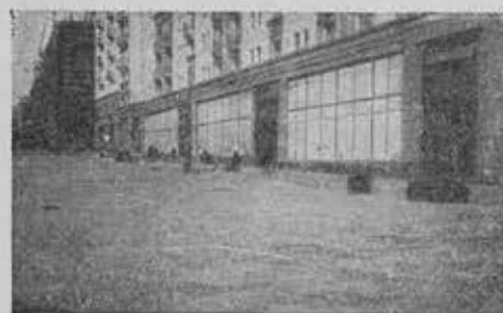
Готовое бетонное основание Fondement en béton achevé
