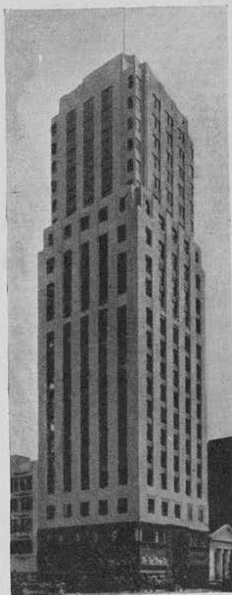
Реконструкция небоскреба в Сан-Франциско (общий вид здания после реконструкции)
