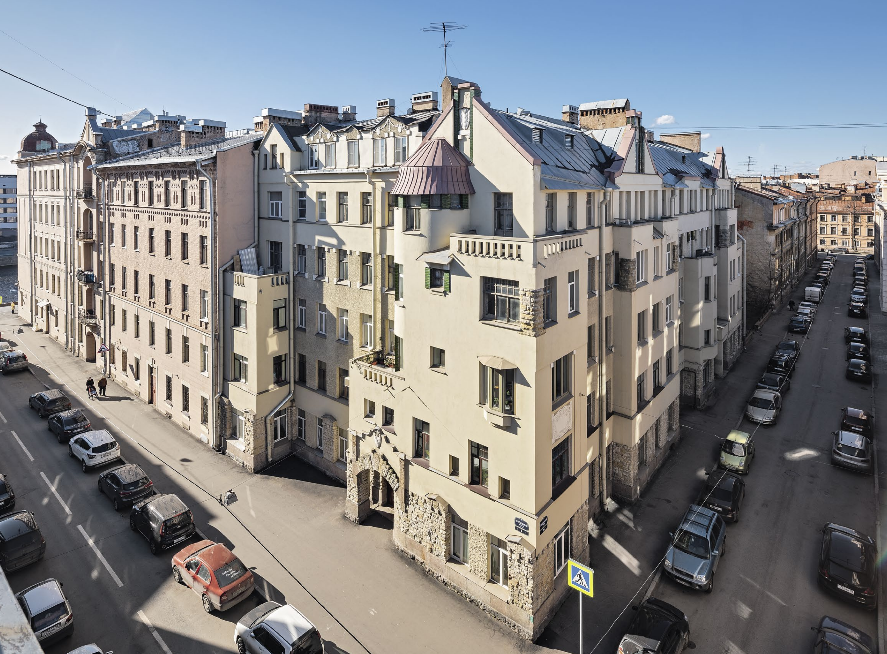
Доходный дом Е.А.Рыбиной. Вид с угла Прядильного и Люблинского переулков Фото 2020. И. Смелов
