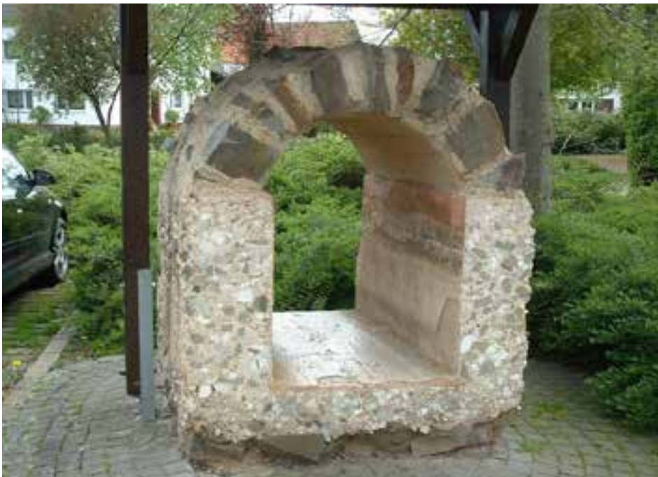
Qədim Roma beton boru kəmərinin bir hissəsi
