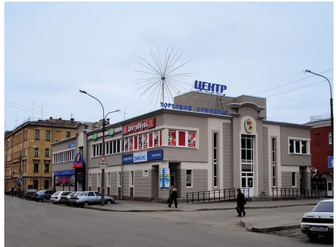
Офисно-торговое здание в Кронштадте.
