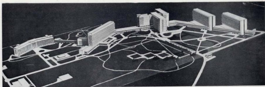
Здание полносборное с укрупненными элементами сборки. Это дало возможность осуществить его строительство вместе с проектированием за 3,5 года. Сооружение в целом ясно по архитектурно-технологическому строю: на белых пилонах вертикальных коммуникаций, облицованных белым камнем, покоится огромная, площадью 3 га, впазданная кровля, облицованная снизу золотистым алюминием и перекрывающая одновременно оба манежа и все вспомогательные залы сооружения.
