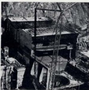
Рамная конструкция покрытия машинного зала Саяно-Шушенской ГЭС [разработчик рамы — МАРХИ]
