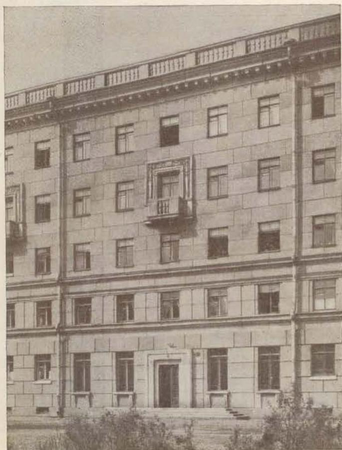
Фрагмент дома с двухрядной разрезкой из трех видов блоков на этаж. Архитекторы В. Журавлев, А. Кац, А. Сибиряков
