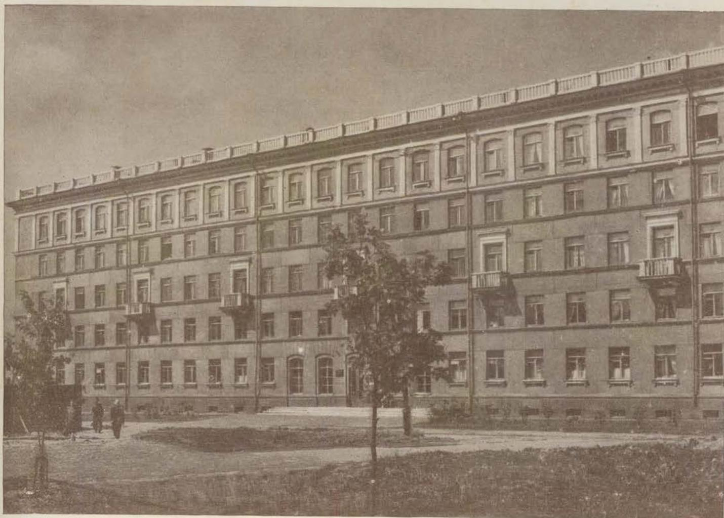
Крупноблочный дом с двухрядной разрезкой из двух видов блоков в этаже, корпус 2 в квартале 15. Архитектор И. Чайко
