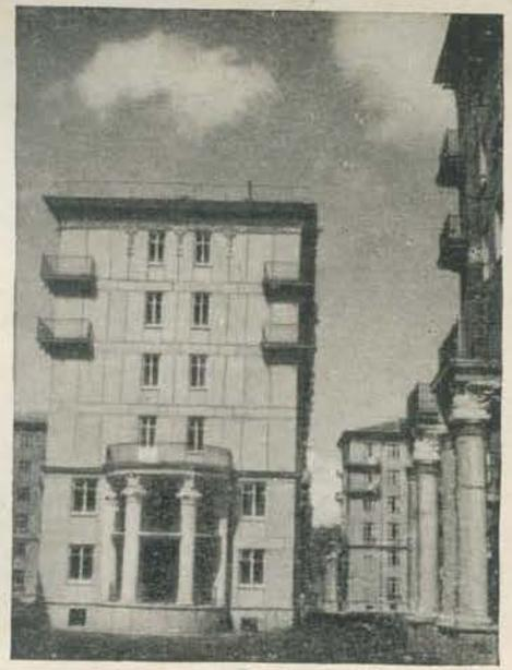
удачно разработанные ленинградскими архитекторами типовые секции со средней продольной несущей стеной позволяют применять одни и те же сборные элементы перекрытий, лестниц и перегородок как в кирпичном, так и крупноблочном строительстве.
