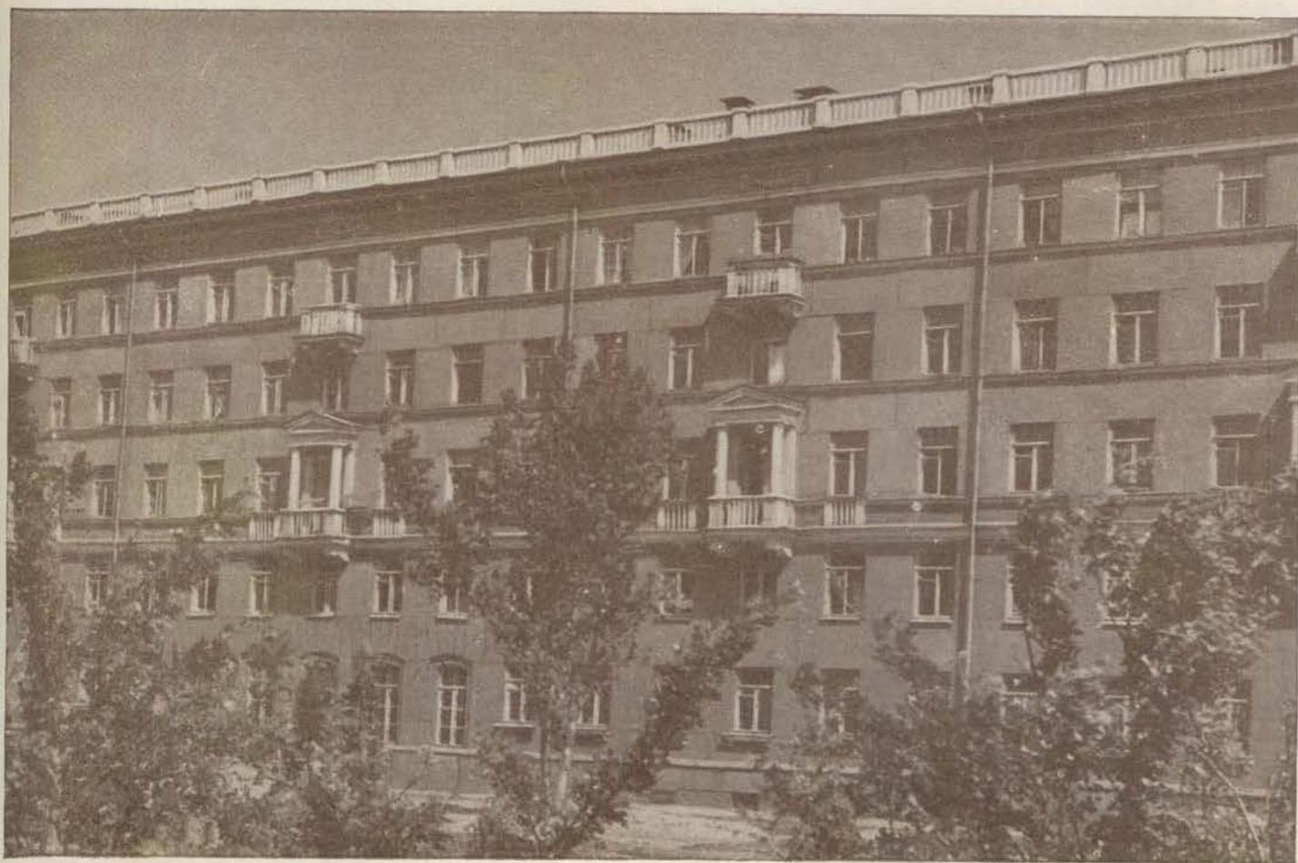
Крупноблочный дом с двухрядной разрезкой из двух видов блоков в этаже. Корпус 22 в квартале 21. Архитектор И. Чайко
