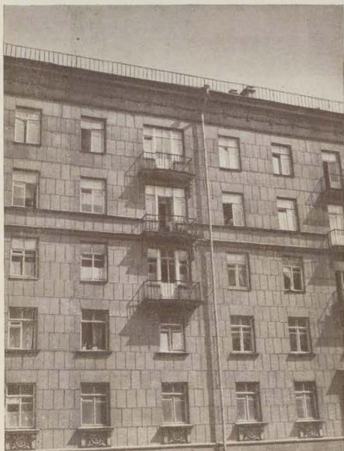
Фрагмент крупноблочного жилого дома с ложной разрезкой на блоках. Архитекторы В. Журавлев, В. Зотов
