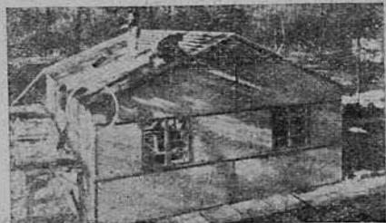
Рис. 18, 19. Установка заранее заготовленных заводским способом дверных и оконных рам. Заделка соединительных швов
