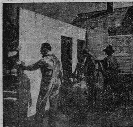
Рис. 10. Монтаж сборного дома фирмы «Хомазот». Установка стен
