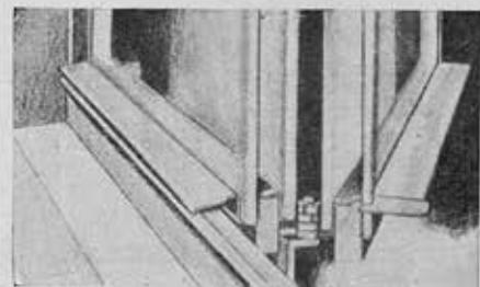
по плотности и теплопроницаемости окно с простым парным переплетом превосходит на 10—15% окно с переплетом из двух створок, навешенных на один навес.
