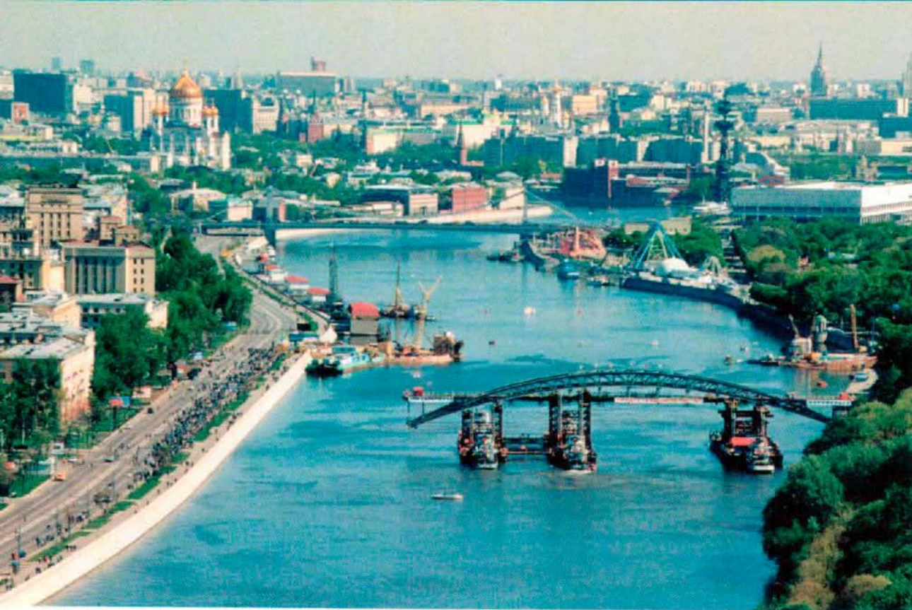
Фрагмент транспортировки Андреевского моста
